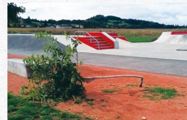
Quelques exemples de dégradations et de pollution constatés sur notre commune.
